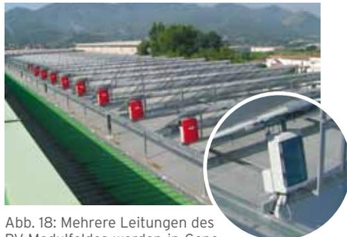
Abb. 18: Mehrere Leitungen des PV-Modulfeldes werden in Generatoranschlusskästen zusammengeführt. Von hier aus gelangen die Hauptleitungen zum Wechselrichter. Die einzelnen Modulleitungen sind untereinander mit Steckverbindern gekoppelt. Diese dürfen nicht geöffnet werden, da dabei die Gefahr eines Lichtbogens besteht.
