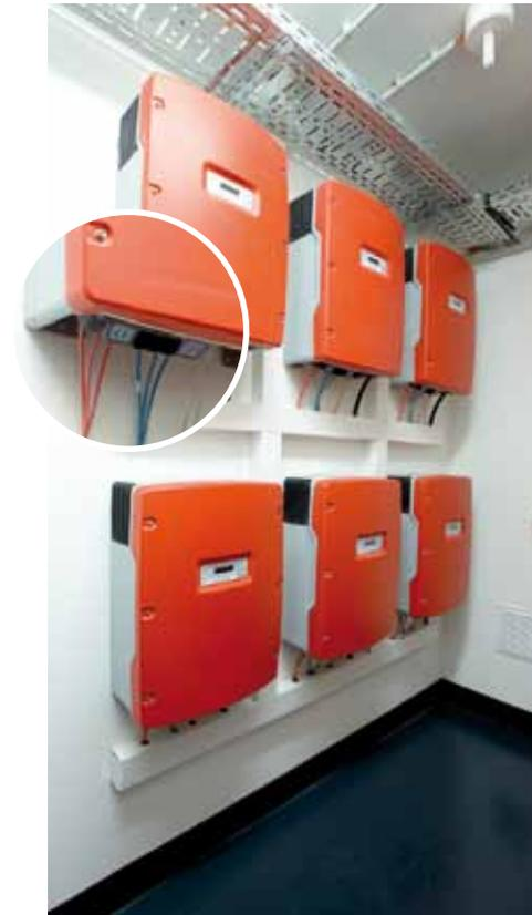
Abb. 19: Wechselrichter können, je nach Gebäudesituation, wie hier im Hausanschlussraum oder aber auch an anderer Stelle installiert sein. Links unten an den Wechselrichtern sind die integrierten DC-Freischalter zu erkennen.
